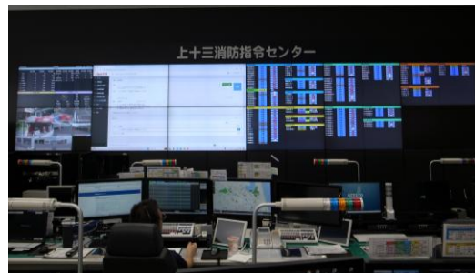
車両運用等情報表示盤（12面）
