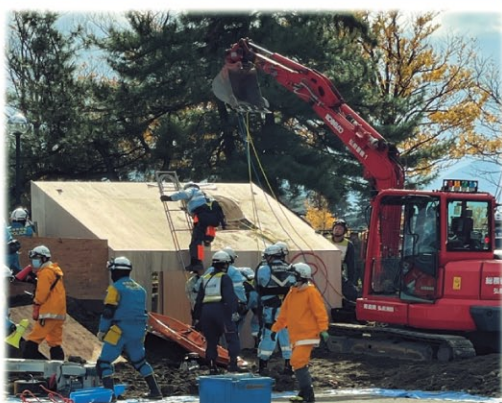
▲令和6年度青森県総合防災訓練における土砂災害対応訓練風景
