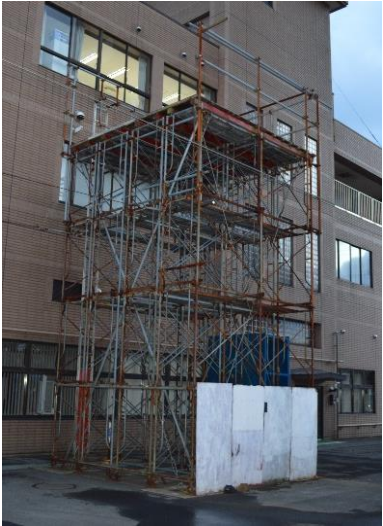
(解体前の旧施設)
